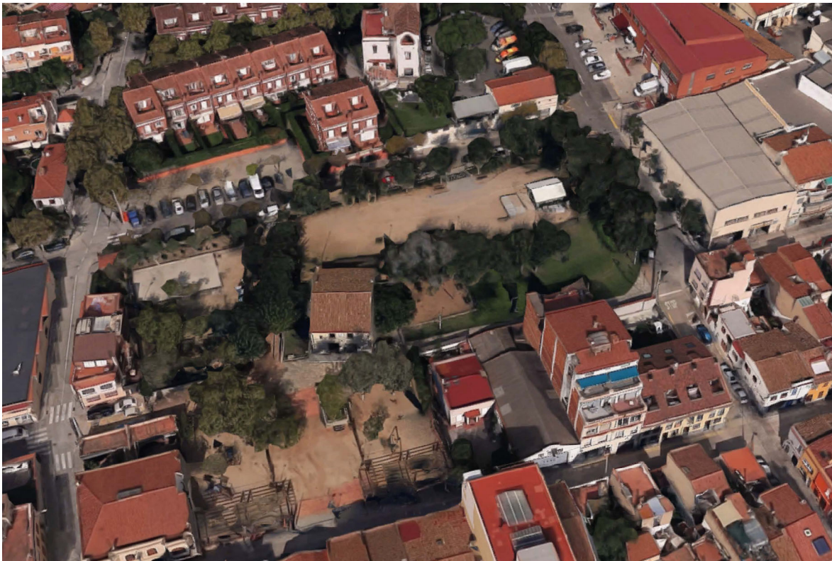
Sub-àmbit 6 CAL ROS DE LES CABRES. Edifici amb ús actual de casal d'avis, en el Parc del Mil·lenari
