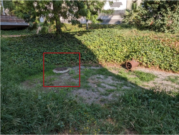
Exemple de sobreeixidor instal·lat en un jardí pluvial:
