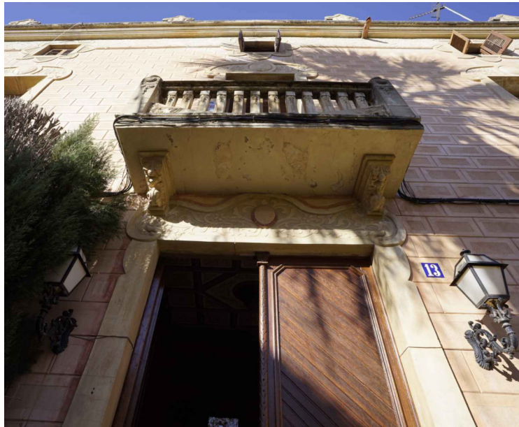
04-IMATGE BALCÓ PRIMERA PLANTA-FAÇANA PRINCIPAL
