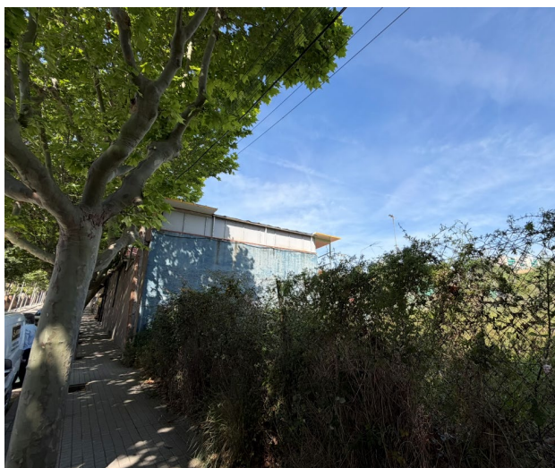
Imatges de la mitgera lateral dels edificis alineats al carrer Sant Lluís, que dona front a l'àmbit d'actuació.
