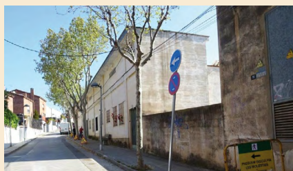
▲ Vista del tram d'obres del c. de Fra Juníper Serra. RAÛL ANDREU
