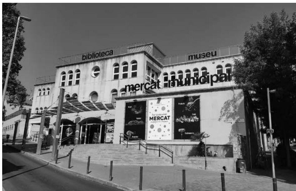
Fotografia actual d'Edifici Centre.
