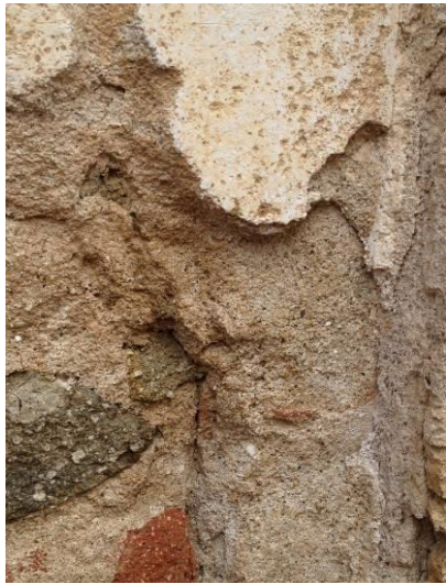
Arrebossat amb acabat emblancat. 1M arrebossat saulo
