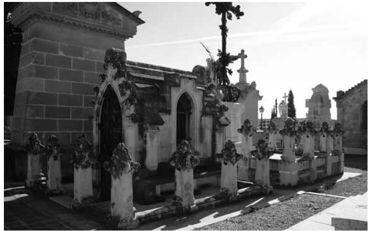
Imatge de l'entrada a la cripta del panteó.
