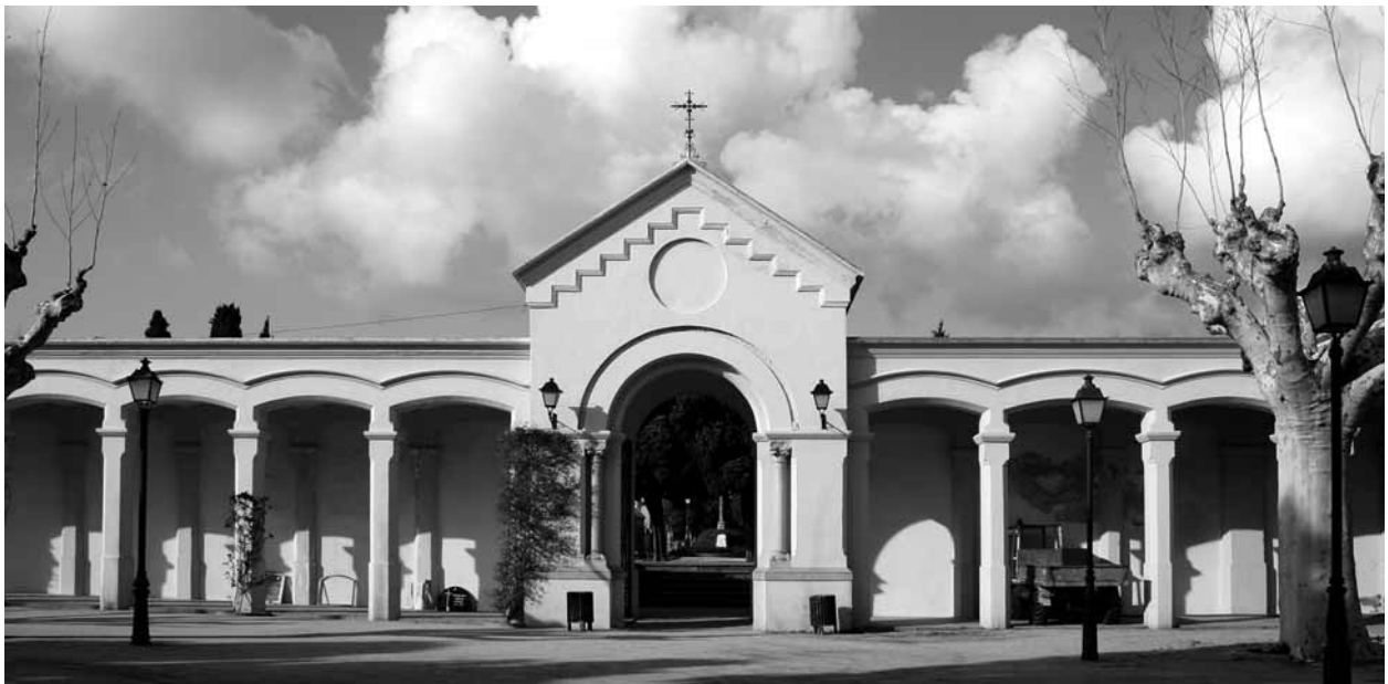
Accés a la zona d'enterrament, on actualment hi ha la tanca de ferro que antigament estava situada a l'entrada del cementiri.
