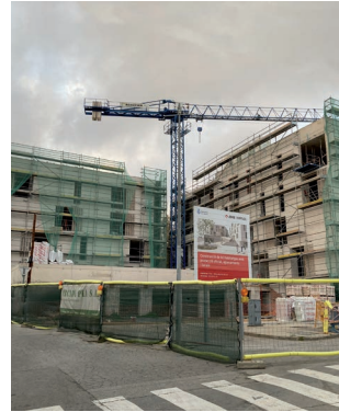
▲ La construcció dels blocs avança a bon ritme. DOMÈNEC CANO
