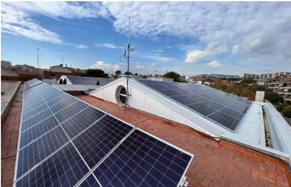
▲ A la coberta de l'Edifici Centre hi ha 183 panells per generar electricitat fotovoltaica. MIREIA CUXART
